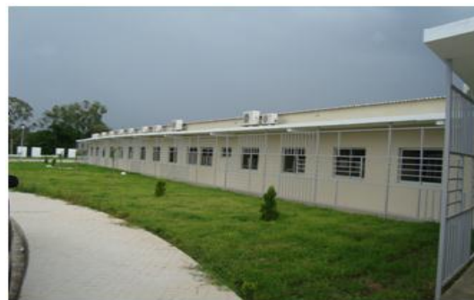
Vista de uno de los 8 Pabellones del Nuevo Hospital Atlántida
