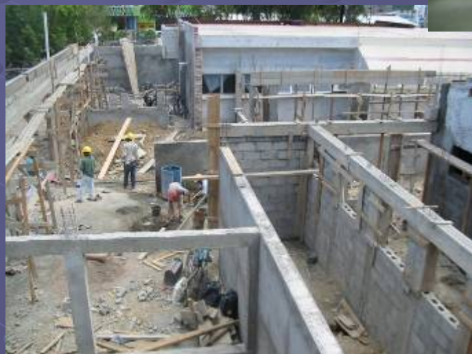
Obras en el Hospital Santa Teresa en Comayagua
